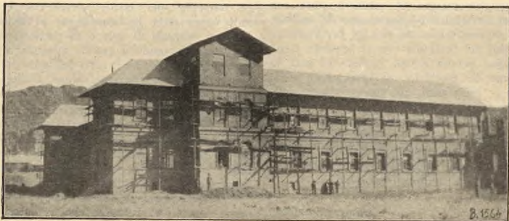
Il lato sinistro della facciata della scuola di Salcedo, lunga m. 112.
